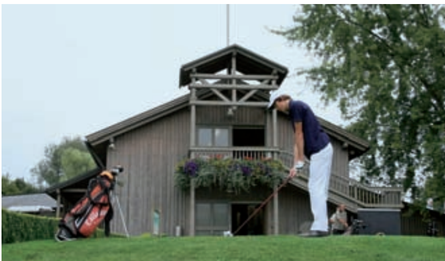
Die Hörner des Alarmsystems sind auf dem Caddyschrank-Trakt des Rottaler Golfclubs montiert; im Vordergrund Tee 10.
